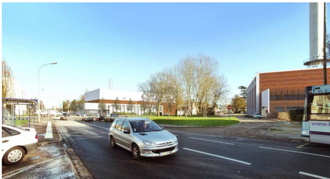
Vue extérieure de la chaufferie ©MRN
