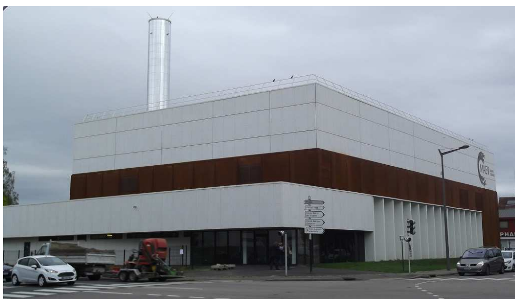
Vue extérieure de la chaufferie ©MRN
